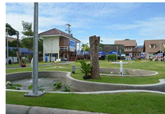
ก่อสร้างระบบบำบัดน้ำเสียขนาดเล็ก
