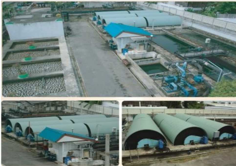
ภาพที่ 4-9 ระบบแผ่นหมุนชีวภาพ (Rotating Biological Contactor: RBC)
