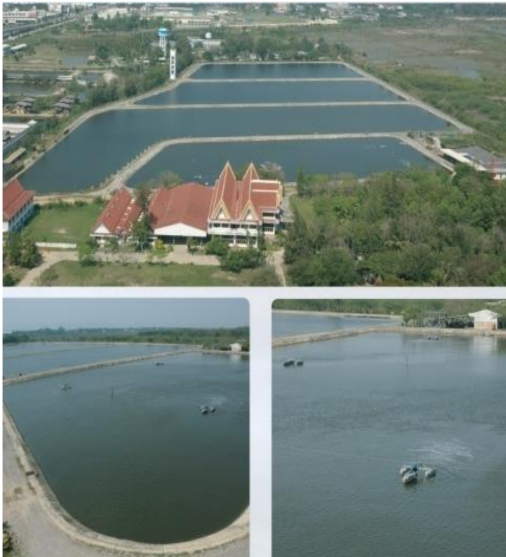
ภาพที่ 4-7 ระบบบ่อเติมอากาศ (Aerated Lagoon: AL)
