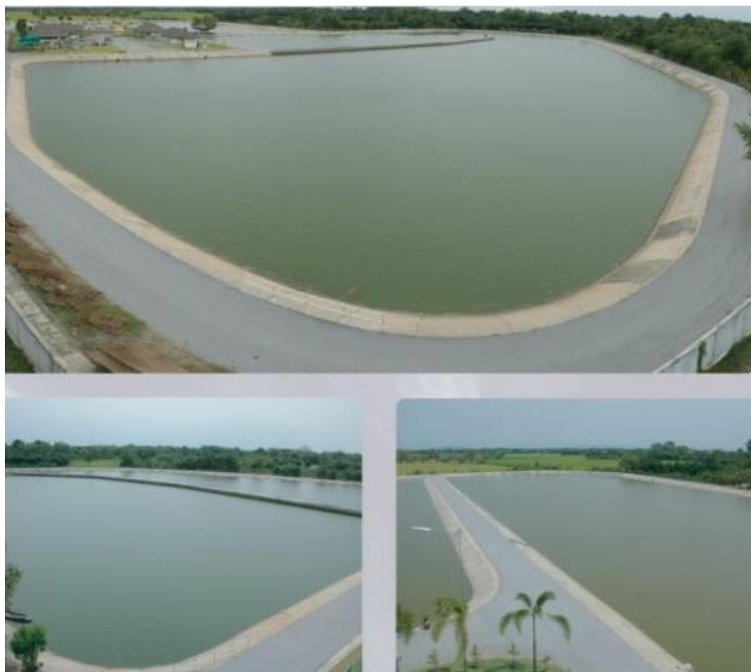
ภาพที่ 4-6 ระบบบ่อปรับเสถียร (Stabilization Pond: SP)
