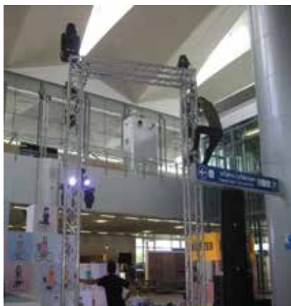
ไม่ใช้อุปกรณ์ Safety Belt ในการปฏิบัติงานบนที่สูง
