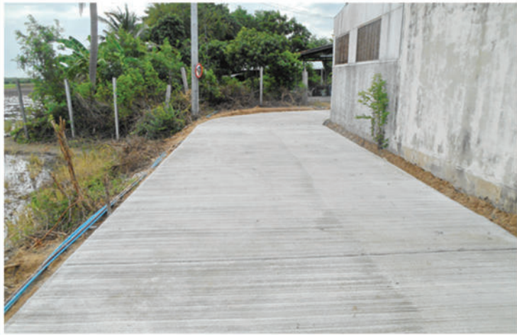
โครงการปรับปรุง ถนน คสล.ดงมะลิ ซอย 5 (ชุมชนดงมะลิ)
