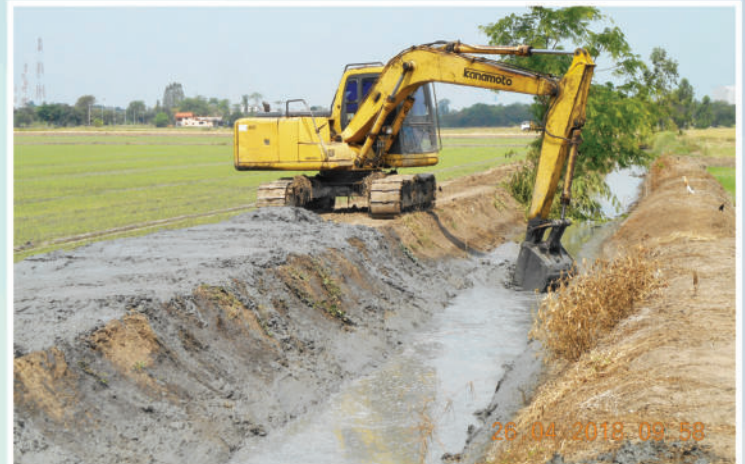
โครงการขุดลอกคุ่งระบายน้ำ จากบริเวณนายกริ อุบล ถึงนายนายมานพ ก่อวงศ์ (ชุมชนดงมะลิ)
