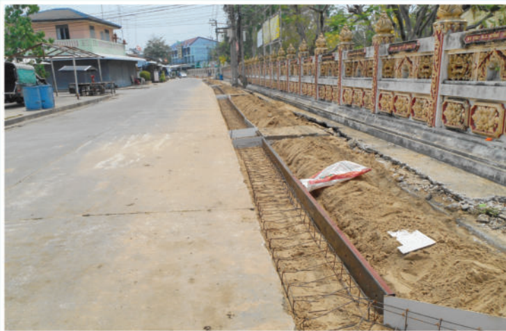
โครงการปรับปรุงซ่อมแซมทางเท้า ริมถนนทางเข้าวัดบางขวาง เริ่มตั้งแต่ถนน 340ฯ (ชุมชนตลาดบางขวาง)
