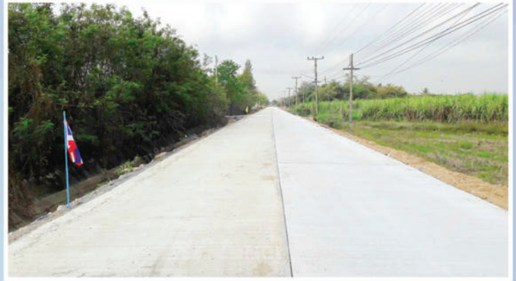
โครงการก่อสร้างถนน คสล.จากสะพานข้ามคลองชลประทาน 1 ขวา ไปทางบ้านสระ (ชุมชนวัดสามชุกฝั่งตะวันตก)
