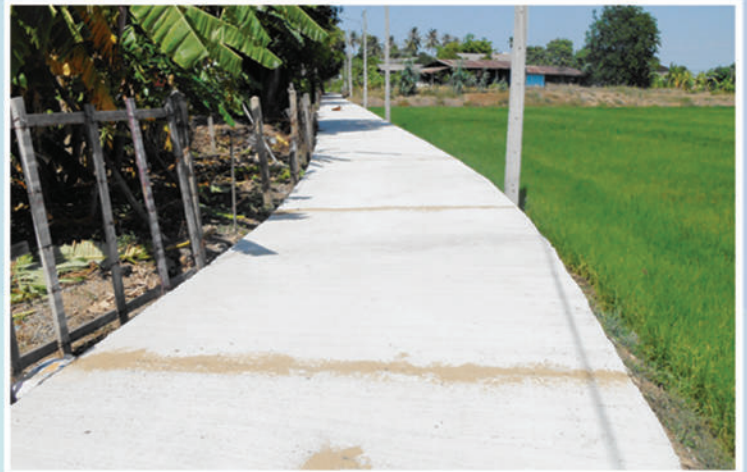
โครงการก่อสร้างยกระดับถนน คสล.ตลาดบ้านทึง ซอย 3 (ชุมชนตลาดบ้านทึง)
