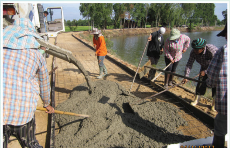
โครงการก่อสร้างถนน คสล.ริมบึงละหารใหญ่ต่อจากของเดิม ไปทางทิศเหนือ (ชุมชนดงมะลิ)
