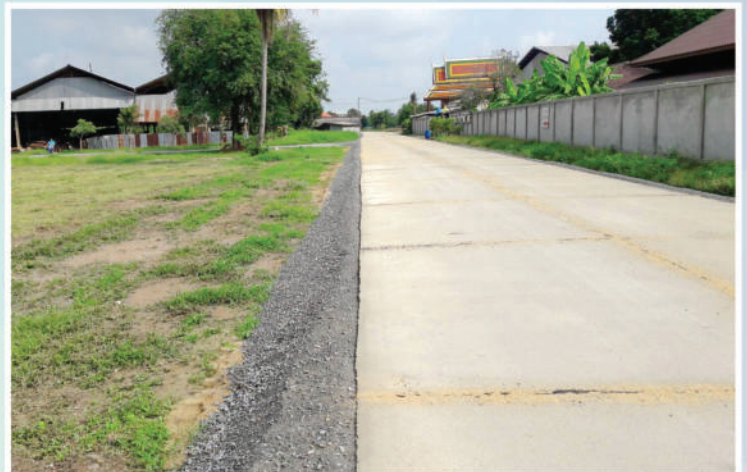
โครงการก่อสร้างถนน คสล.ทางเจ้าวัดศรีจันทร์ภาวนาราม พร้อมวางท่อระบายน้ำ (ชุมชนบ้านประตุน้ำ)
