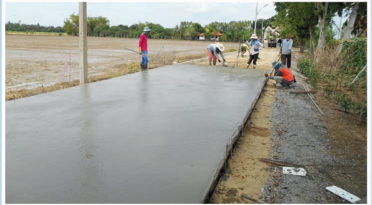
โครงการก่อสร้างถนน คสล.รอบบึงหนองทะเล (ชุมชนวัดบ้านทึง)
