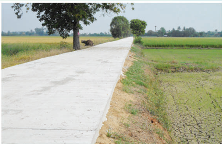
โครงการก่อสร้างถนน คสล.บริเวณทุ่งจัดรูป ซอย 1 ฯ (ชุมชนบ้านคลองหอม)
