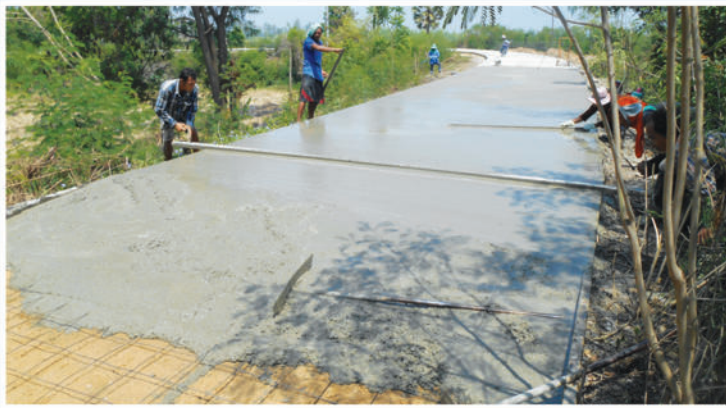
โครงการก่อสร้างถนน คสล. ต่อจากของเดิมบริเวณแอนตันสน ไปทางทิศตะวันตก (ชุมชนเศรษฐกร)
