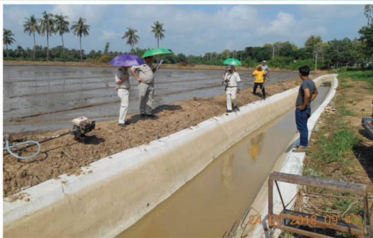
โครงการก่อสร้างคูคอนกรีต คุ่งน้ำจากถนน 340 ถึงนางยุพิน เดียวแก้ว (ชุมชนหลวงพ่อวัดบางแวก)
