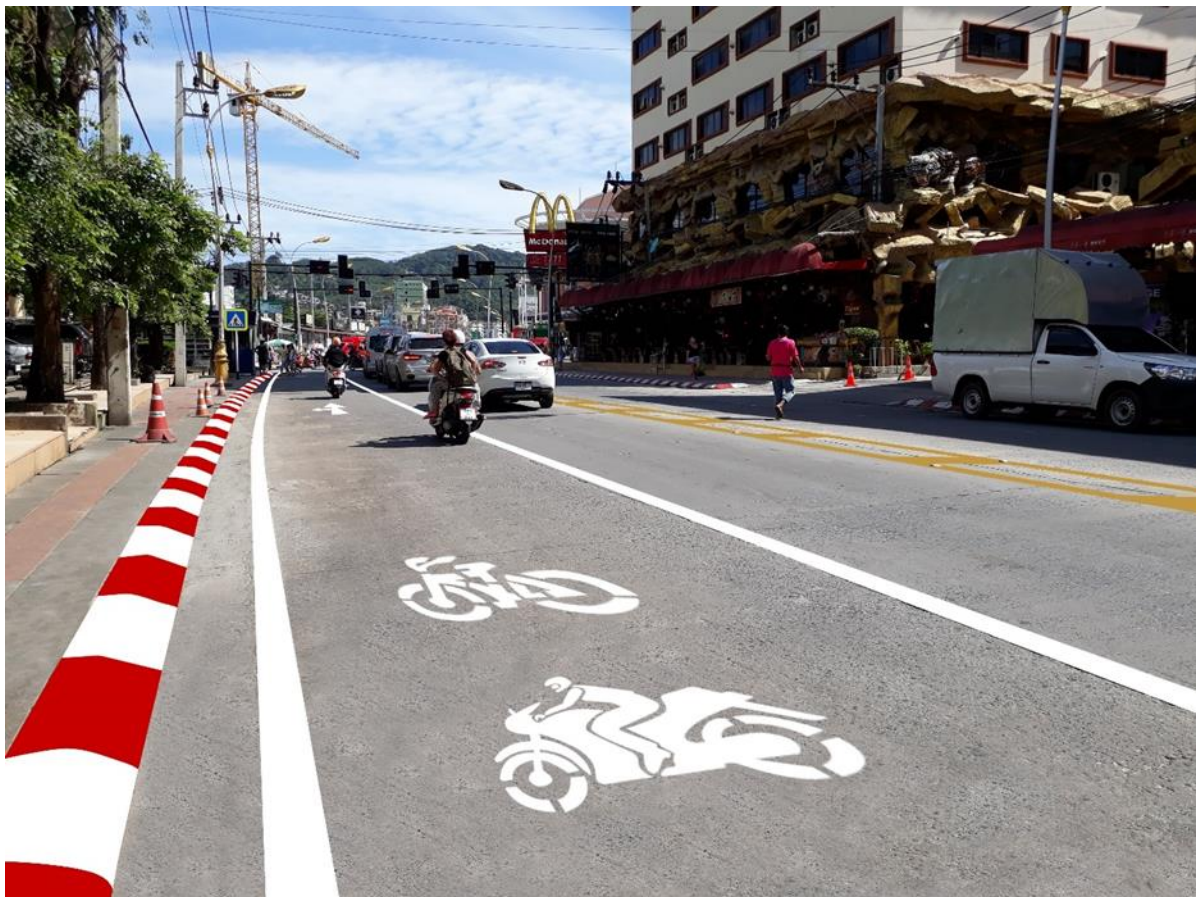
รูปที่ 20 โครงการปรับปรุงผิวจราจรและเครื่องหมายจราจรบนพื้นทางในเขตเทศบาลเมืองปาดอง
