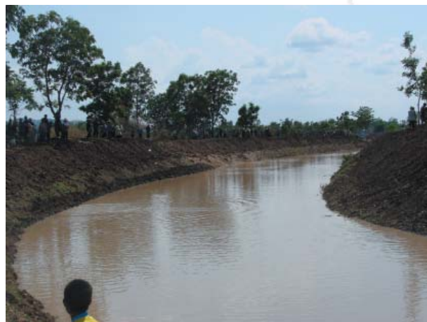
สภาพคลองที่ขุดลอกแล้วตามโครงการขุดลอกคูคลองบ้านหนองบอน หมู่ที่ ๘ คลองระนอง และคลองบ้านหนองอ้ายแมว หมู่ที่ ๑๐ อ.ชุมแสง จ. นครสวรรค์
