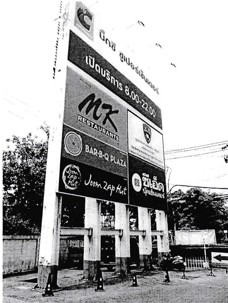
ป้ายที่ติดตั้งบนพื้นดิน
