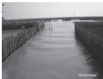
การปักแนวไม้ไผ่กันคลื่น เว้นช่องทางสำหรับ ออกทะเลของชาวบ้าน ที่มา : http://www.oknation.net
