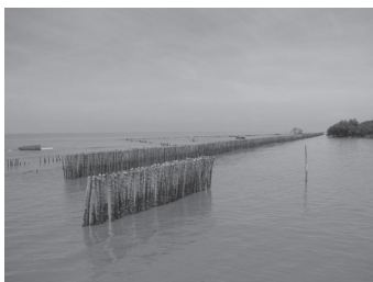
การใช้แนวไม้ไผ่กันการกัดเซาะ ที่มา : http://www.thaimtb.com
