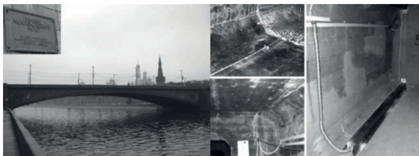
ภาพที่ ๒๐ สะพาน Bolshoi Moskvoretskiy Bridge และการติดตั้งระบบ Structural health monitoring system
