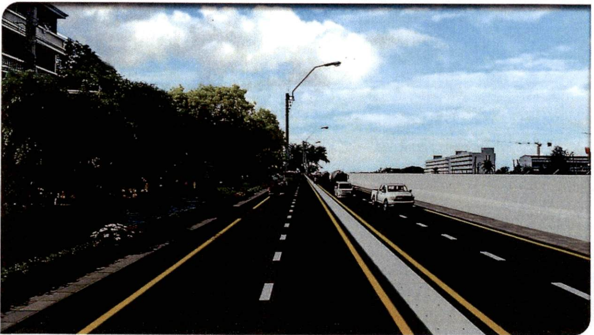
สภาพพื้นที่หลังการดำเนินการ
