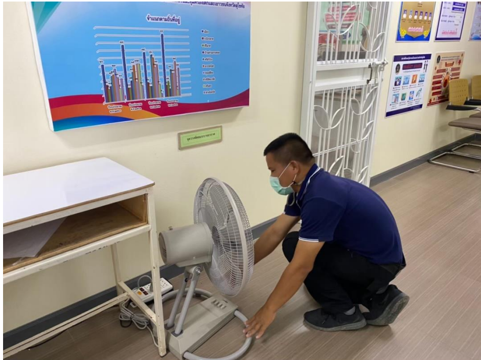
ภาพประกอบจุดที่ ๔ ติดตั้งพัดลมระบายอากาศ ๒ จุด/บริเวณญาติเยี่ยม
