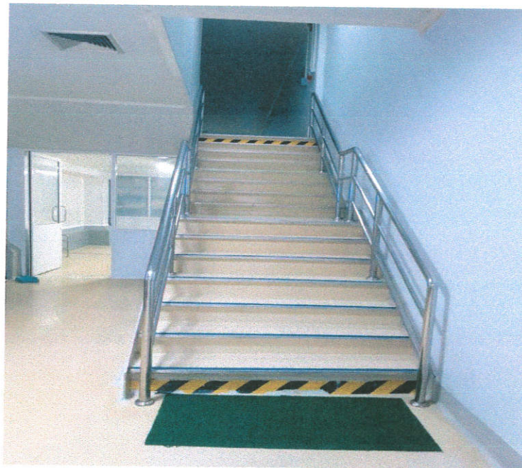
บันไดหนีไฟใช้ร่วม กับบันไดหลัก
