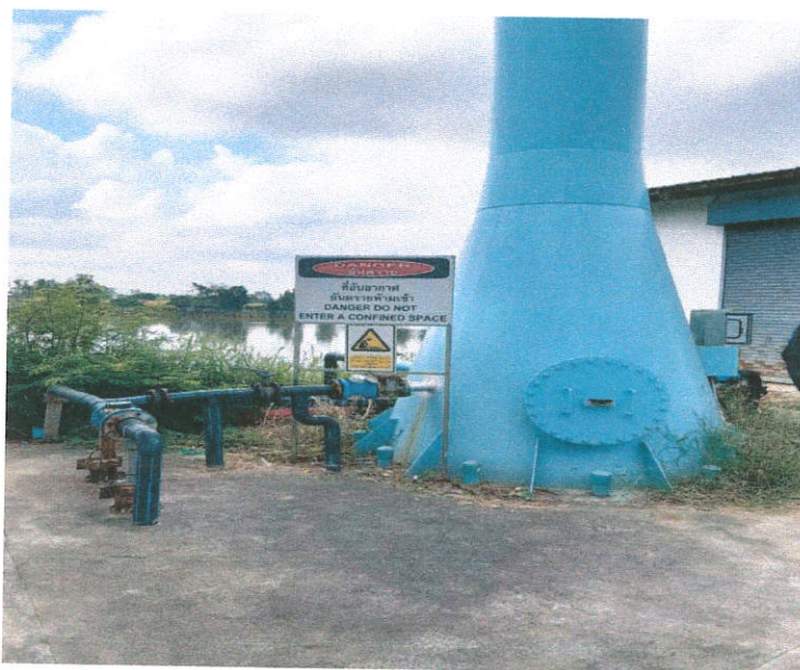
ฐานถังประปา
