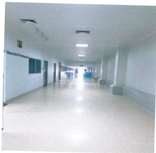
ภายในอาคาร FPP 2
