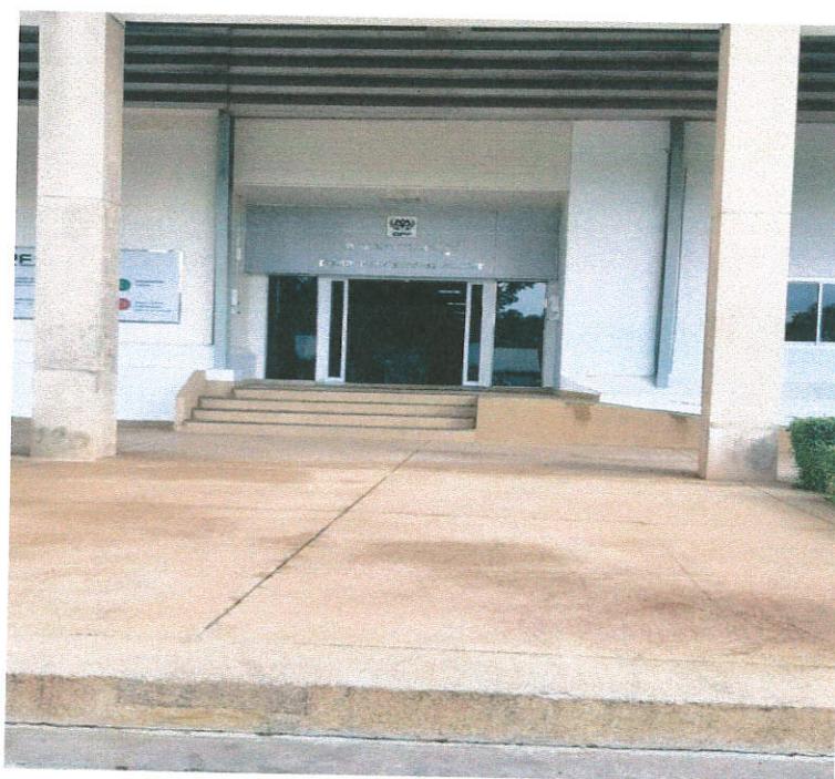
ทางเข้าอาคาร FPP1
