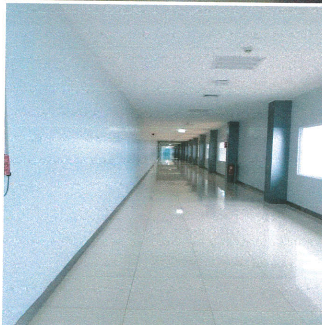
บันไดและทางหนีไฟ
