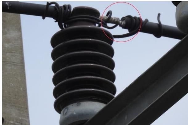
เมื่อตรวจพบสายไฟฟ้าชำรุดและได้เข้าดำเนินการแก้ไขโดยวิธีดับไฟฟ้า ในขั้นตอนการติดตั้ง Preformed Dead End เพื่อติดตั้ง Ratchet hoists ดึงสายไฟฟ้า ได้เกิดการขาดของสายไฟฟ้าขึ้น จึงทำให้ระยะเวลาในการแก้ไขนานเกินกว่าที่ได้ประเมินไว้ในขั้นต้น ซึ่งหากไม่ดำเนินการแก้ไขจะทำให้สายไฟฟ้าขาดเกิดไฟฟ้าขัดข้องสร้างความเดือดร้อนต่อผู้ใช้ไฟฟ้า ดังนั้นผู้ปฏิบัติงานจึงมีความต้องการอุปกรณ์ที่จะนำมาเสริมในขั้นตอน การดำเนินการที่ต้องมีความมั่นคง เสริมสร้างความปลอดภัย สามารถปฏิบัติงานได้อย่างไม่ขัดข้องและต่อเนื่อง
