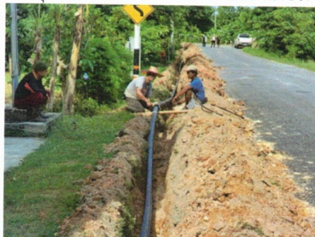
ปรับปรุงซ่อมแซมและขยายเขตท่อเมนส่งน้ำประปา หมู่ที่ ๑๓ บ้านเขากลาง
