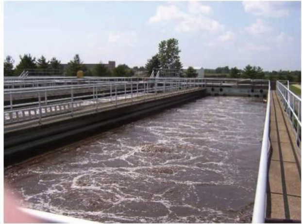
บ่อบำบัดน้ำเสีย
