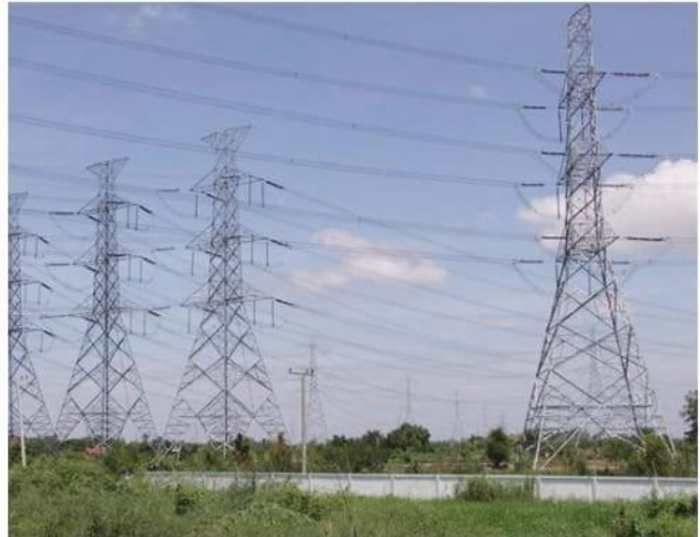
เสาไฟฟ้า
