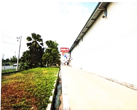
ระบบท่อน้ำทิ้ง พร้อมใช้งาน
