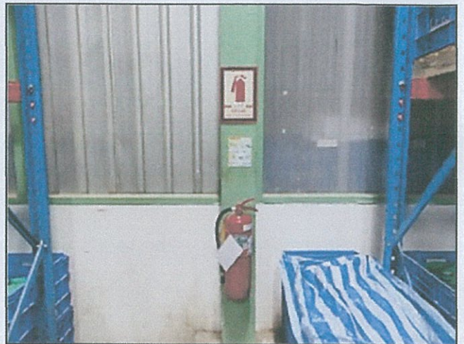
ถังดับเพลิง
