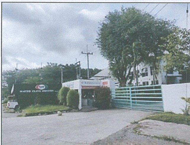
ทางเข้าอาคาร
