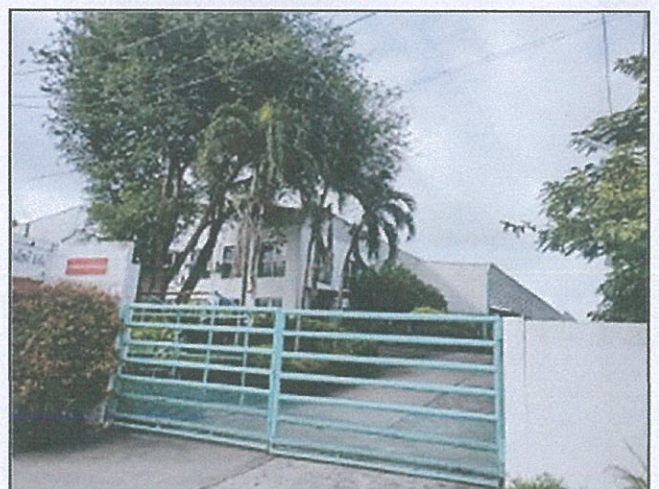
ทางเข้าอาคาร
