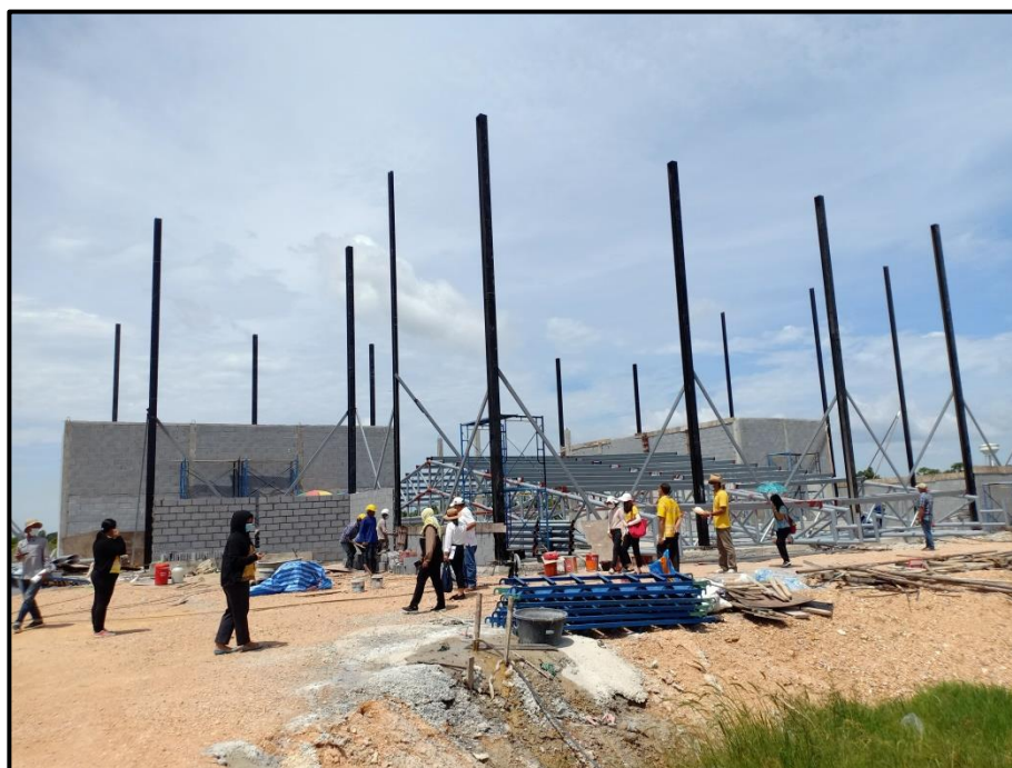
อาคารโรงสีข้าว ขนาดพื้นที่ ๑,๐๖๐ ตารางเมตร
