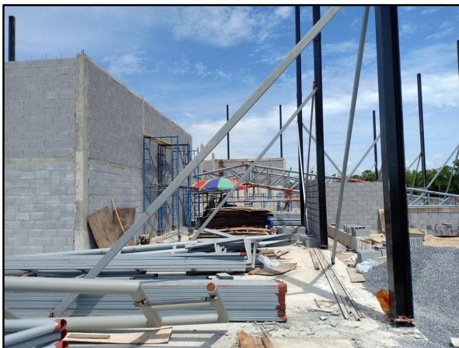
บริเวณพื้นที่ภายในตัวอาคารโรงสีข้าว
