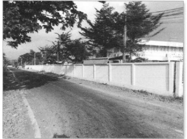
(ข) จัดระเบียบสายไฟสายสื่อสารโดยรอบสำนักงาน
