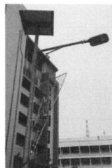
(ข) รูปการปรับปรุงไฟถนนเป็นโคมโซลาร์เซลล์
