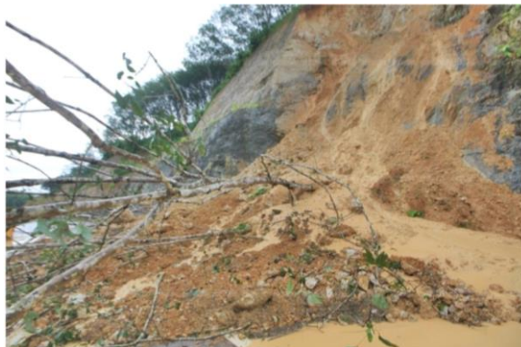
รูปที่ ๒๓ เหตุการณ์ดินถล่ม
