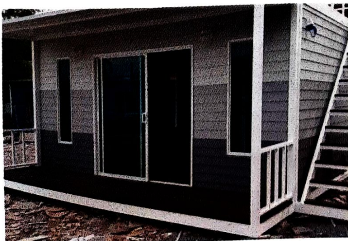
บ้านประกอบเสร็จ
