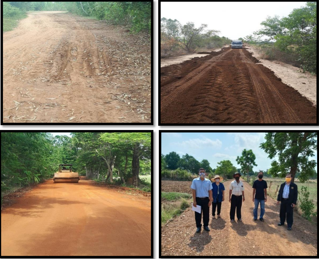
๓. โครงการซ่อมแซมถนนดินลูกรัง บ้านหนองสังข์ หมู่ที่ ๑ (จากถนนสาย ๓๔๘ – บ้านนายไพร ทองสร้อย)
