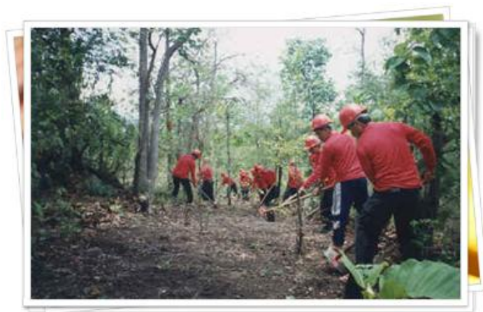
การทำแนวกันไฟด้วยแรงงานคน
