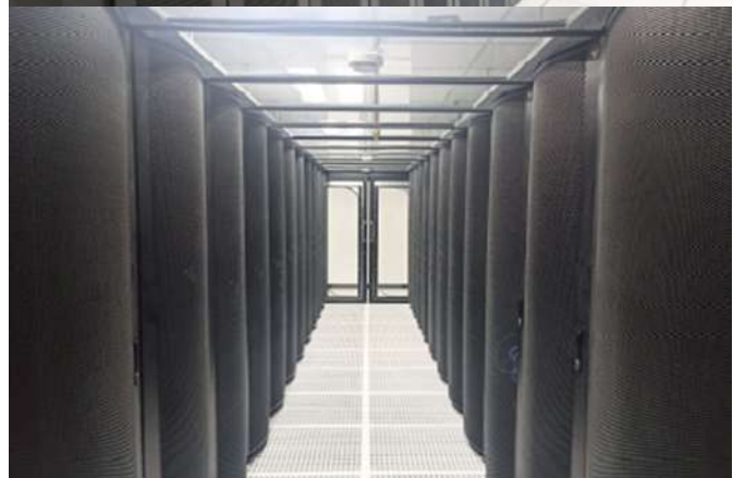
ติดตั้งตู้ RACK ระบบสายสัญญาณ ทั้งหมดแล้ว
