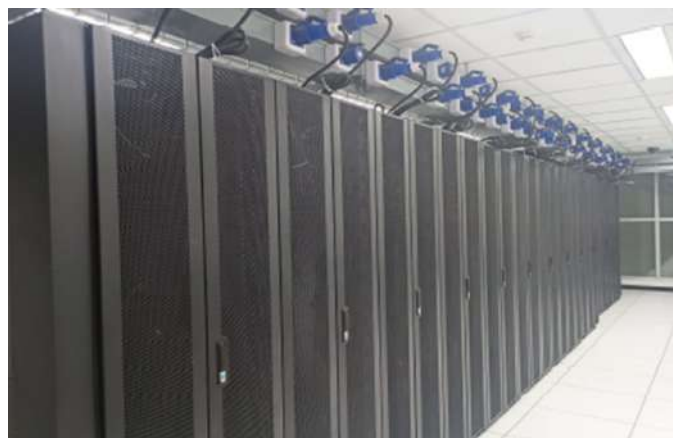
ติดตั้งงานระบบจ่ายกำลังไฟฟ้าต่อเนื่อง (แบบเตวอร์) ทั้งหมดแล้วเสร็จ
