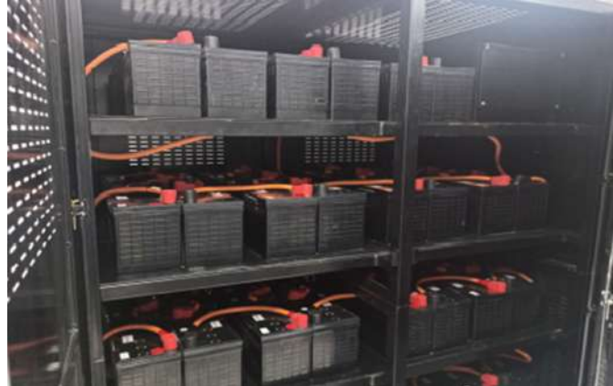
ติดตั้งงานระบบจ่ายกำลังไฟฟ้าต่อเนื่อง (แบบเตวอร์) ทั้งหมดแล้วเสร็จ
