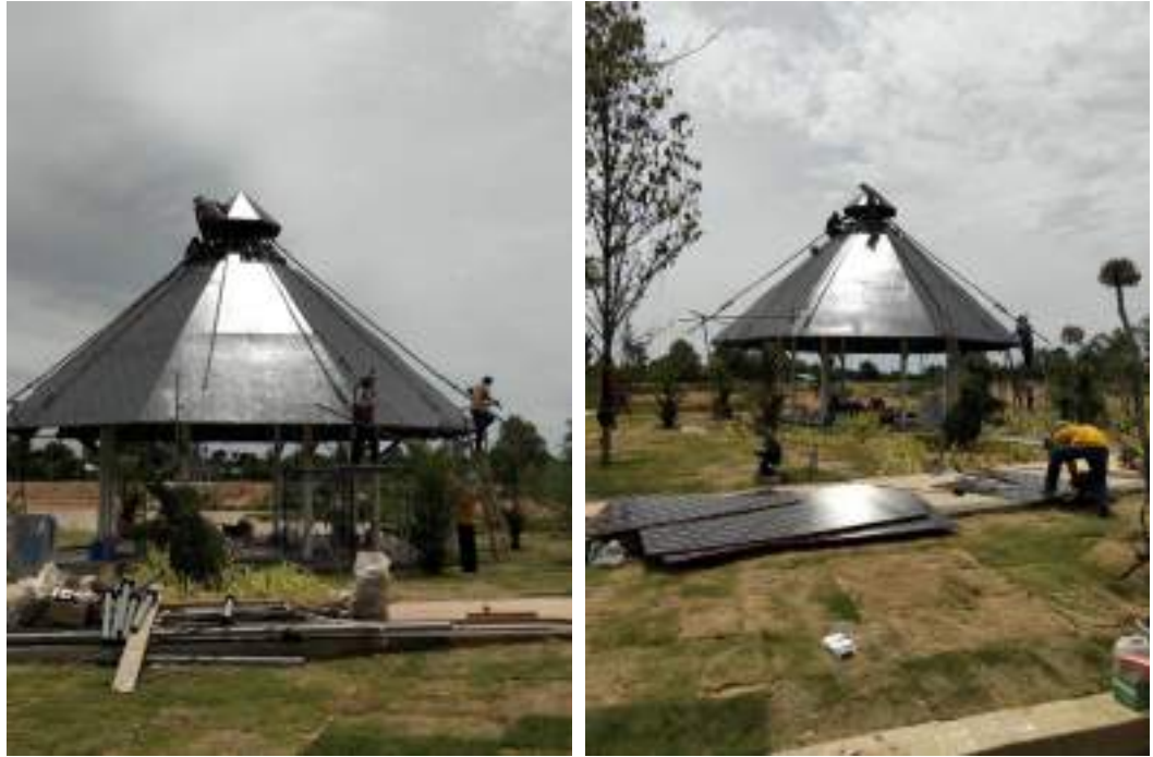
งานศาลาพักผ่อนข้าง แล้วเสร็จ ๘๐%
