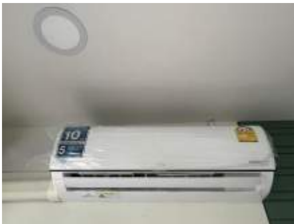
งานติดตั้งเครื่องปรับอากาศ
