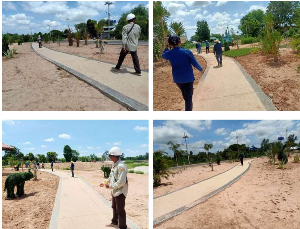
งานวางระบบรดน้ำต้นไม้ แล้วเสร็จ ๑๐๐%
