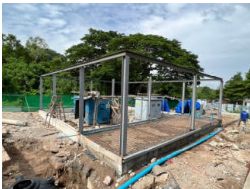
งานติดตั้งเสาเหล็กและคานเหล็ก ชั้น 2 (จุดอาคารเอนกประสงค์ จุดที่ 2 + ห้องน้ำ)
