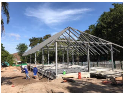
งานติดตั้งโครงสร้างเหล็กเสาและโครงสร้างหลังคา (จุดอาคารเอนกประสงค์ 3+4)
