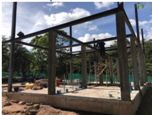
งานติดตั้งโครงสร้างเหล็กเสาและโครงสร้างหลังคา (จุดอาคารเอนกประสงค์ 3+4)
