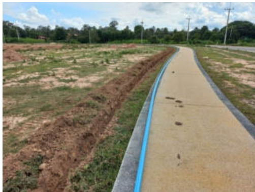
งานวางระบบรดน้ำต้นไม้ แล้วเสร็จ ๒๐%
