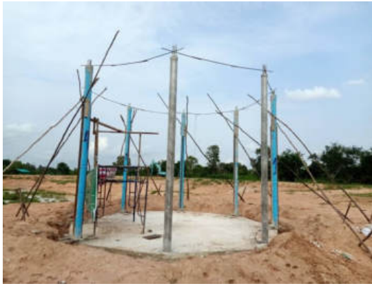
งานศาลาพักผ่อนข้าง แล้วเสร็จ ๒๐%
