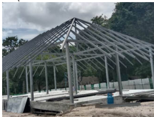
งานติดตั้งโครงสร้างเหล็กเสาและโครงสร้างหลังคา (จุดอาคารเอนกประสงค์ 3+4)
