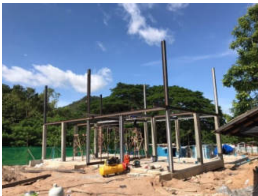
งานติดตั้งโครงสร้างเหล็กเสาและโครงสร้างหลังคา (จุดอาคารเอนกประสงค์ 3+4)
