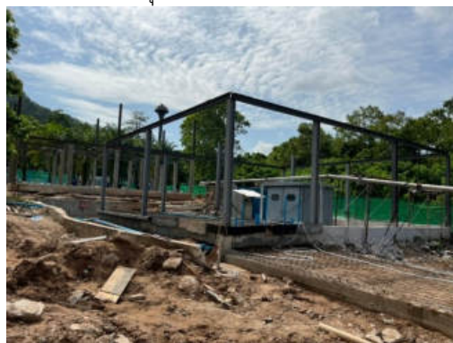
งานติดตั้งเสาเหล็กและคานเหล็ก ชั้น 2 (จุดอาคารเอนกประสงค์ จุดที่ 2 + ห้องน้ำ)
