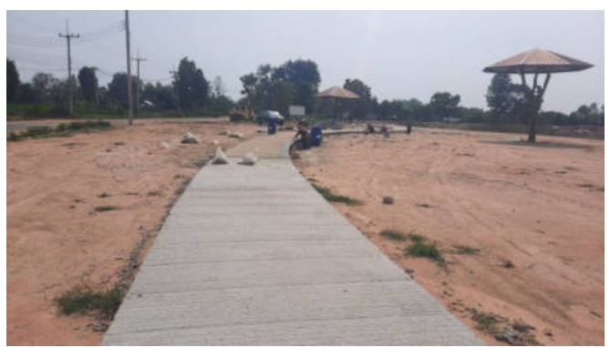
งานเทคอนกรีตและปรับระดับ ทางเดินข้าง แล้วเสร็จ ๑๐๐%
