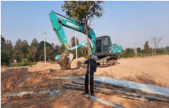
งานโครงสร้างฐานราก ทางเดินช้าง
