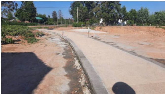
งานวางผังทางเดินและเทคอนกรีตปรับระดับ แล้วเสร็จ ๑๐๐%
