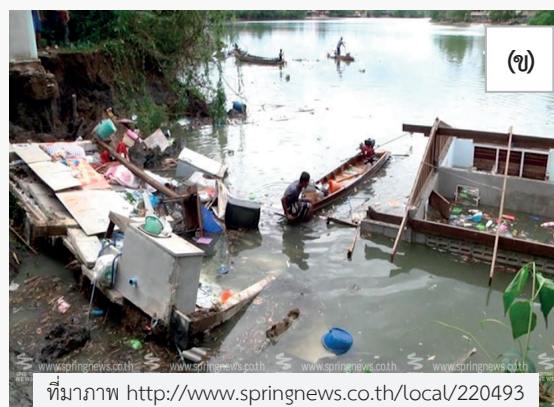
รูปที่ 4-4 เหตุการณ์ตลิ่งทรุดที่พบบริเวณริมฝั่งแม่น้ำแม่กลอง ในเขตจังหวัดสมุทรสงคราม (ก)-(ข) ฝั่งแม่น้ำแม่กลองทรุดตัวพังทลาย บริเวณเลขที่ 25/1 ตำบลบางขันแตก อำเภอเมืองสมุทรสงคราม ทำให้บ้านหลังพังลงไปในแม่น้ำ
