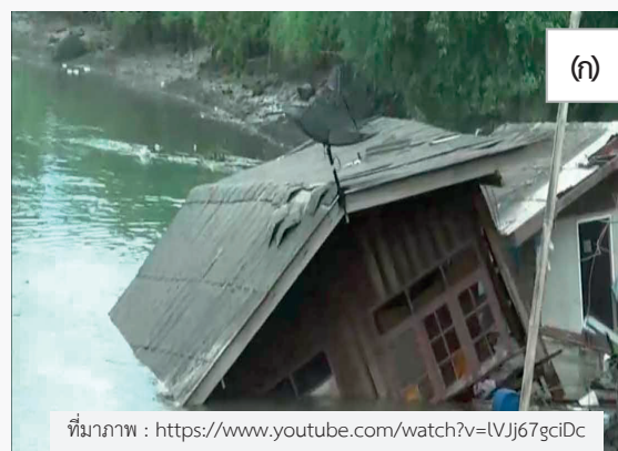
รูปที่ 4-4 เหตุการณ์ตลิ่งทรุดที่พบบริเวณริมฝั่งแม่น้ำแม่กลอง ในเขตจังหวัดสมุทรสงคราม (ก)-(ข) ฝั่งแม่น้ำแม่กลองทรุดตัวพังทลาย บริเวณเลขที่ 25/1 ตำบลบางขันแตก อำเภอเมืองสมุทรสงคราม ทำให้บ้านหลังพังลงไปในแม่น้ำ
