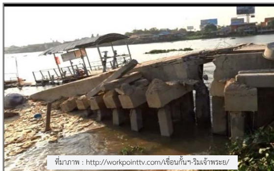
รูปที่ 4-5 การทรุดตัวของเขื่อนคอนกรีตกั้นน้ำเซาะริมแม่น้ำเจ้าพระยา หมู่ที่ 2 ตำบลปากเกร็ด อำเภอปากเกร็ด จังหวัดนนทบุรี
