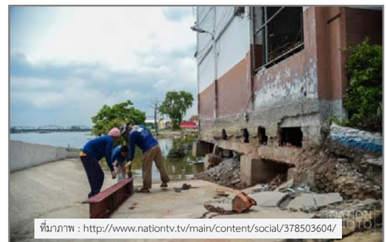
รูปที่ 4-4 การทรุดตัวของเสาอาคารเรียนโรงเรียนวัดสลักเหนือ หมู่ที่ 5 ตำบลบ้านใหม่ อำเภอกาบัง จังหวัดน่าน
