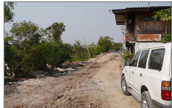
รูปที่ 4-6 การทรุดตัวของถนนคอนกรีตเสริมเหล็กเลียบคลองขุนศรี หมู่ที่ 4 ตำบลไทรใหญ่ อำเภไทรน้อย จังหวัดนนทบุรี
