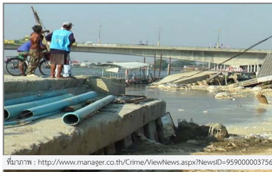
รูปที่ 4-5 การทรุดตัวของเขื่อนคอนกรีตกั้นน้ำเซาะริมแม่น้ำเจ้าพระยา หมู่ที่ 2 ตำบลปากเกร็ด อำเภอปากเกร็ด จังหวัดนนทบุรี
