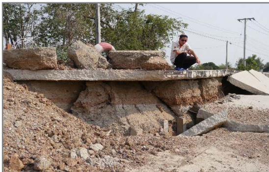
รูปที่ 4-6 การทรุดตัวของถนนคอนกรีตเสริมเหล็กเลียบคลองขุนศรี หมู่ที่ 4 ตำบลไทรใหญ่ อำเภไทรน้อย จังหวัดนนทบุรี
