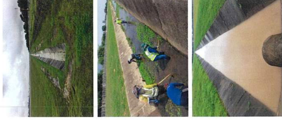
รูปภาพการปฏิบัติงานขุดลอกรางในเขตพื้นที่ AIRSIDE ท่าอากาศยานเชียงใหม่
