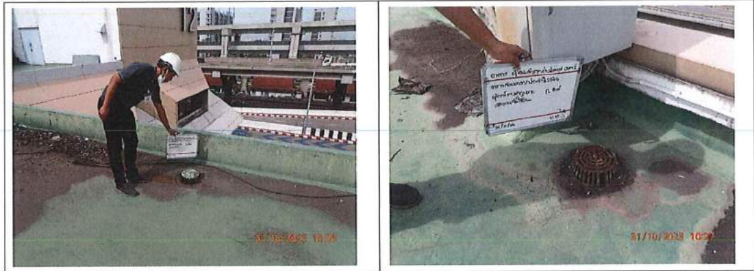
รายละเอียด ตรวจสอบสภาพท่อและวางระบายน้ำรอบอาคารไม่พบขยะ และการอุดตันของท่อระบายน้ำฝน
