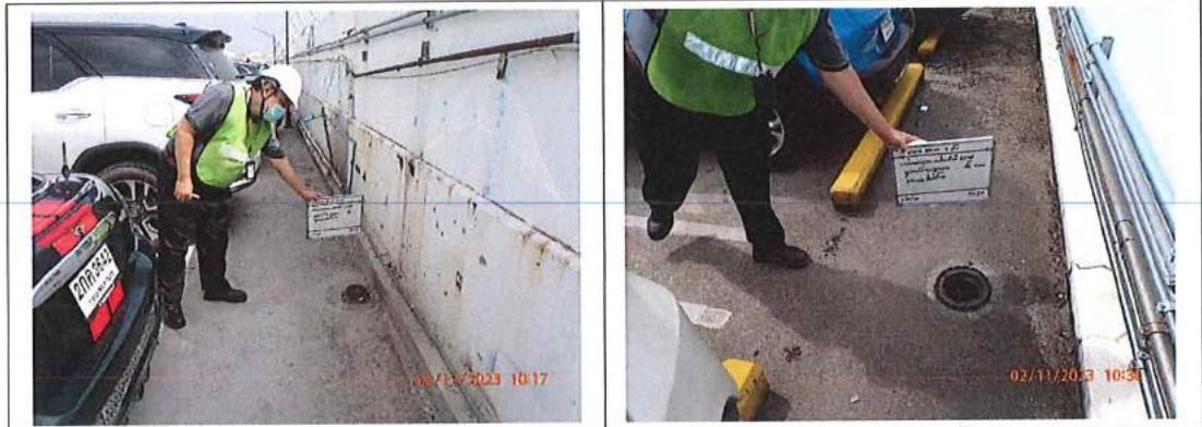
รายละเอียด ตรวจสอบสภาพท่อและรางระบายน้ำรอบอาคารไม่พบขยะ และการอุดตันของท่อระบายน้ำฝน
