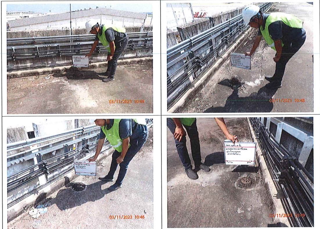
รายละเอียด ตรวจสอบสภาพท่อและรางระบายน้ำรอบอาคารไม่พบขยะ และการอุดตันของท่อระบายน้ำฝน
