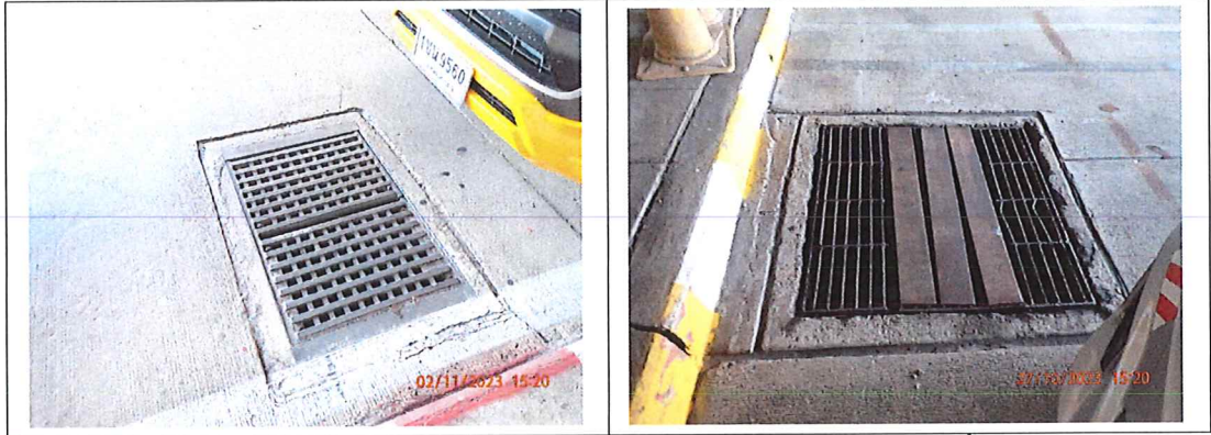
รายละเอียด ตรวจสอบสภาพท่อและรางระบายน้ำรอบอาคารไม่พบขยะ และการอุดตันของท่อระบายน้ำ
