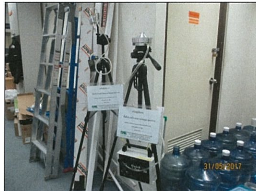
อาคารวิศวกรรมและเทคโนโลยีสารสนเทศ ชั้น 2 : ฝ่ายระบบคอมพิวเตอร์และเครือข่าย
