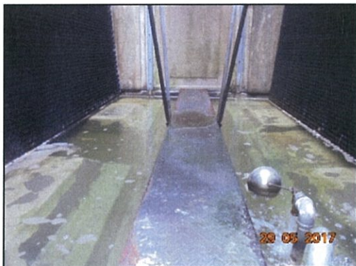
รูปที่ 6 รูปแสดงตัวอย่างวิธีการเก็บตัวอย่าง เชื้อแบคทีเรียกลุ่มลิสต์อีโอสลอส สปีชีส์ ในหอฝึ่งเย็น
