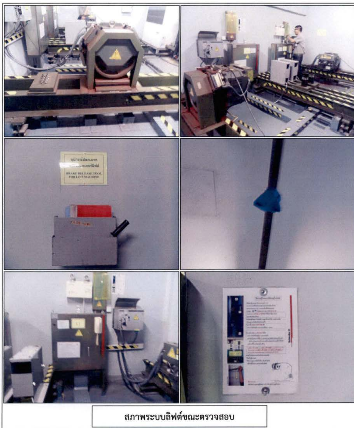
รูปแสดง สภาพระบบลิฟต์ขณะตรวจสอบ
