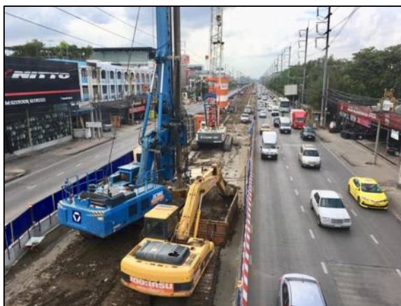
รูปที่ 2.13-1 ตัวอย่างการเจาะเสาเข็ม Bored pile และ Barrett pile
