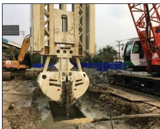
รูปที่ 2.13-1 ตัวอย่างการเจาะเสาเข็ม Bored pile และ Barrett pile
