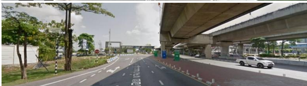
รูปที่ 2.1-4 ภาพถ่ายปัจจุบันบริเวณก่อนทางแยกสัญญาณไฟ บริเวณสนามเอส ซี จี สเตเดียม ช่วงปลายของแนวเส้นทางรถไฟฟ้า
