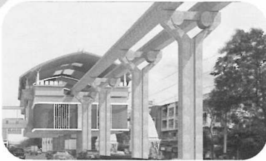
รูปโครงสร้างทางวิ่งของรถไฟฟ้ารางเดี่ยว
