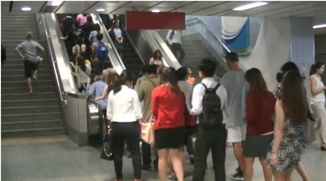
รูปที่ 3.4-3 ลักษณะทางกายภาพของบันไดเลื่อนในสถานที่สำรวจ
