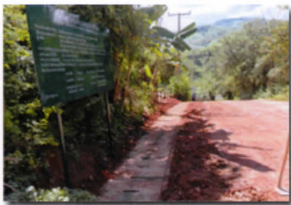
โครงการก่อสร้างรางระบายน้ำ คสล. พร้อมฝาดปิด ซอย ๒ หมู่ที่ ๑๒ บ้านผาใต้
