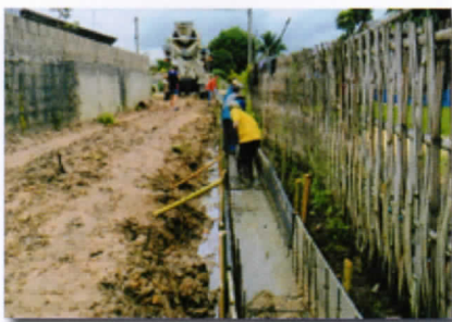
โครงการก่อสร้างรางระบายน้ำ คสล. พร้อมฝาปิด ซอย ๔ ห่อมบ้านแสม หมู่ที่ ๑๕
