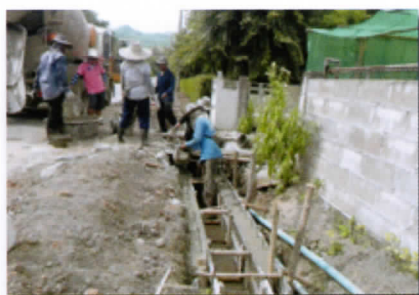
โครงการก่อสร้างรางระบายน้ำ คสล. พร้อมฝาดปิด หมู่ที่ ๙ บ้านเมืองงาม
