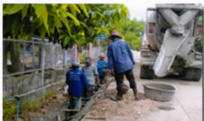
โครงการก่อสร้างรางระบายน้ำ คสล. พร้อมฝาดปิดบริเวณ ซอย เด่นห้า หมู่ที่ ๓ บ้านท่าตอน
