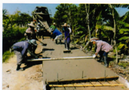
โครงการก่อสร้างถนน คสล. หมู่ที่ ๒ บ้านห้วยมะเฟืองเชื่อม หมู่ที่ ๓ บ้านท่าตอน
