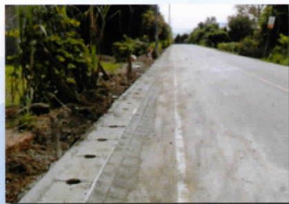
โครงการก่อสร้างรางระบายน้ำ คสล. พร้อมฝาดปิด หมู่ที่ ๙ บ้านเมืองงาม
