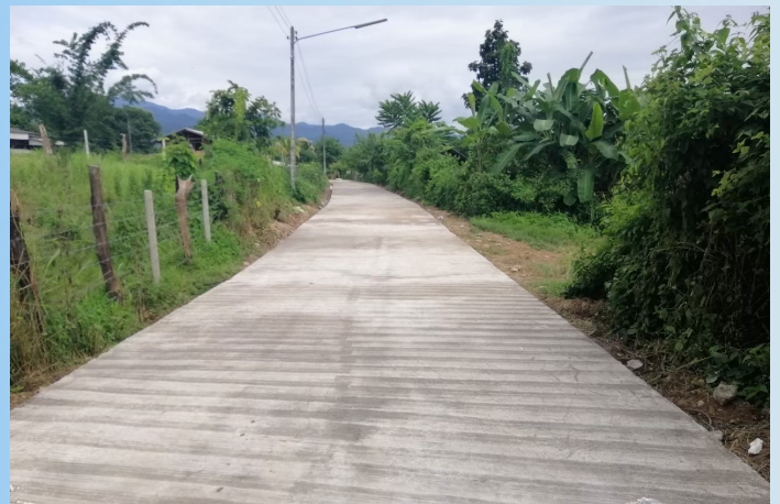
โครงการถนนคอนกรีตเสริมเหล็กบ้านแม่ทองแป
