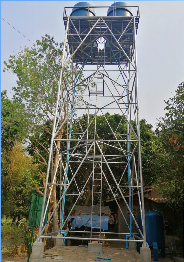
โครงการก่อสร้างหอดึงสูงบ้านกะปวง
