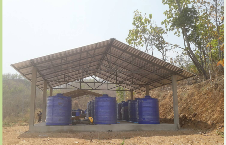
โครงการก่อสร้างอาคารพร้อมถังเก็บน้ำ บ้านห้วยโพ
