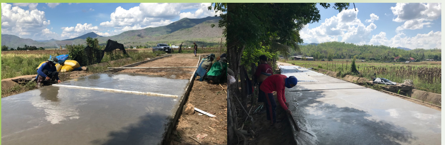
โครงการก่อสร้างถนนคอนกรีตเสริมเหล็กเข้าพื้นที่การเกษตร บ้านทุ่งแพม
