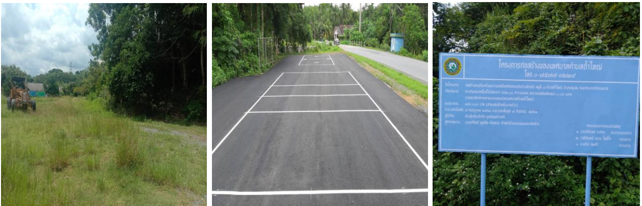
26. โครงการอุดหนุนการไฟฟ้าส่วนภูมิภาคอำเภอทุ่งสง และการไฟฟ้าส่วนภูมิภาคอำเภอรัตนพิบูลย์ งบประมาณ 993,647.11 บาท
