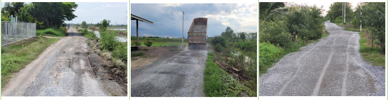
๖. ลงหินคลุกซ่อมแซมถนนภายในหมู่บ้านคลองขวิด หมู่ที่ ๔
