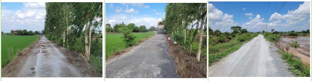
๑๔. ก่อสร้างถนนคอนกรีตเสริมเหล็กบริเวณเชิงสะพานแขวนข้ามแม่น้ำท่าจีน ฝั่งหมู่ที่ ๘
