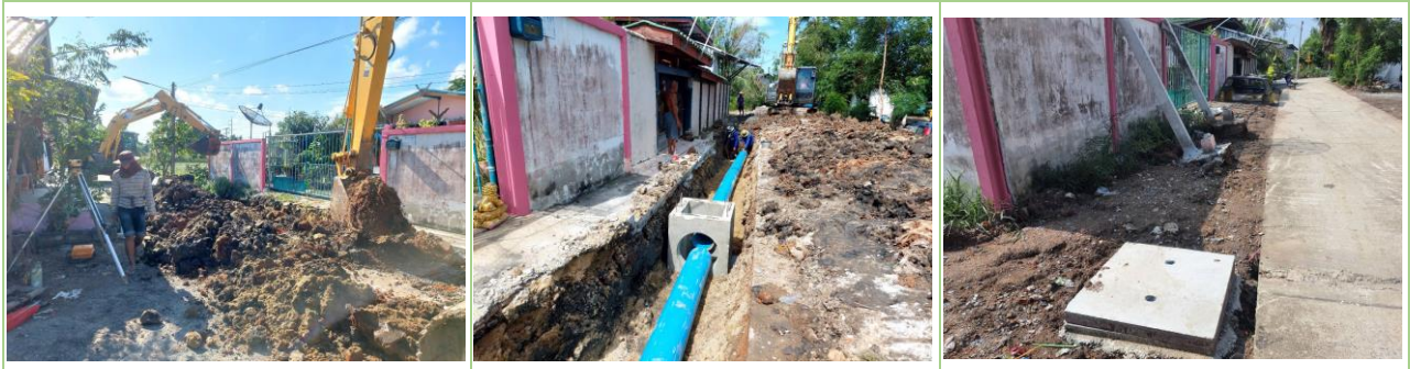
๑๑. วางท่อระบายน้ำภายในหมู่บ้านคลองท่อ หมู่ที่ ๖
