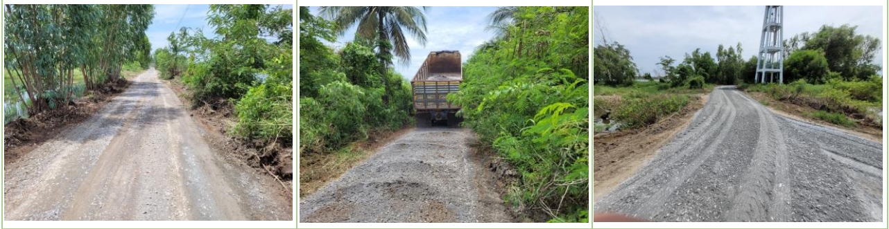
๕. ลงหินคลุกซ่อมแซมถนนสายเลียบบคลองหนองชะโด หมู่ที่ ๓ หมู่ที่ ๙
