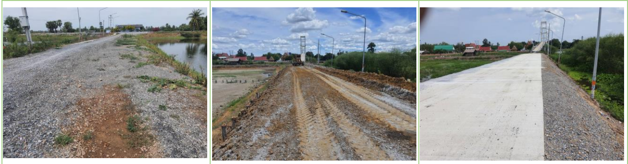
๑๕. ลงหินคลุกซ่อมแซมถนนสายเลียบแม่น้ำท่าจีน หมู่ที่ ๘
