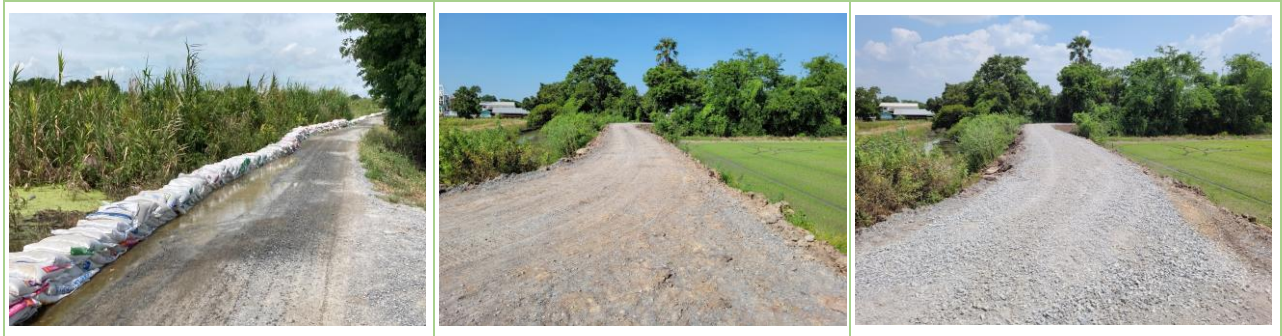
๑๕. ลงหินคลุกซ่อมแซมถนนสายเลียบแม่น้ำท่าจีน หมู่ที่ ๘
