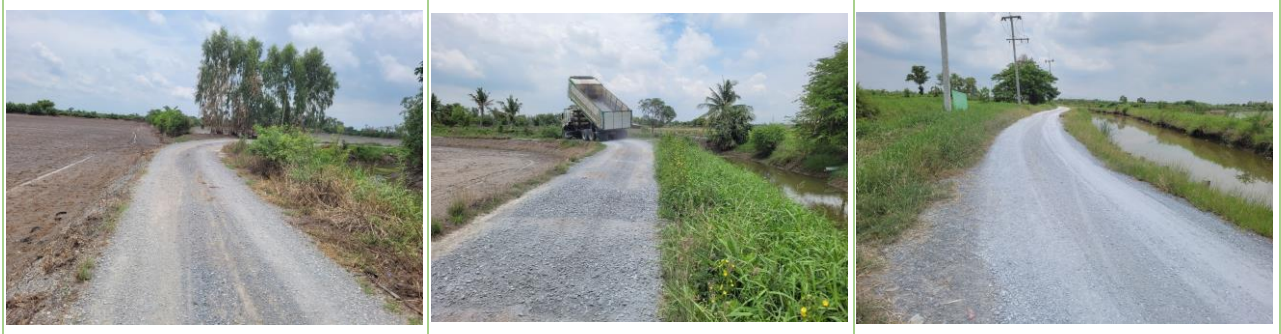
๑๐. ก่อสร้างถนนคอนกรีตเสริมเหล็กสายเลียบคลอง สปก.เอ หมู่ที่ ๖
