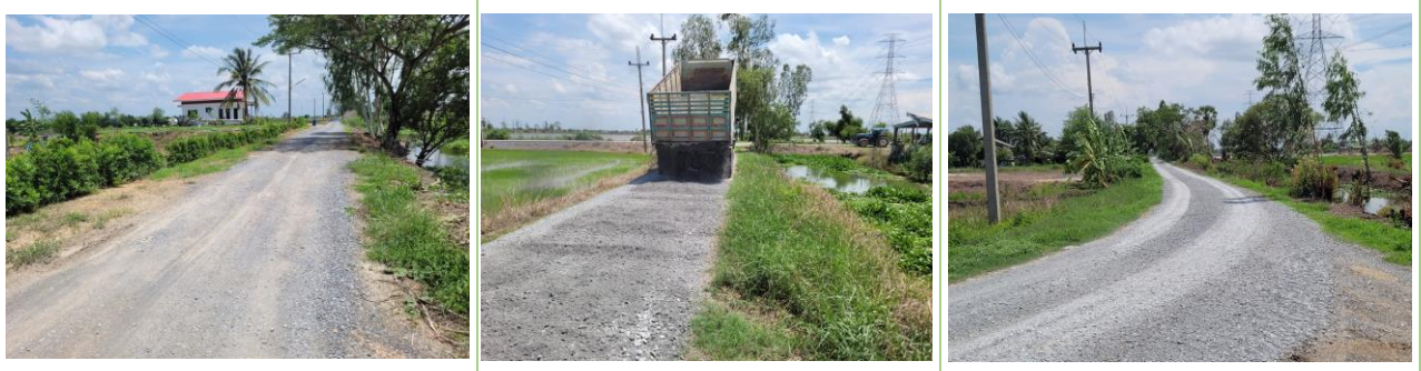
๑๙. ลงหินคลุกซ่อมแซมถนนภายในหมู่บ้านหนองปรัง หมู่ที่ ๑๑
