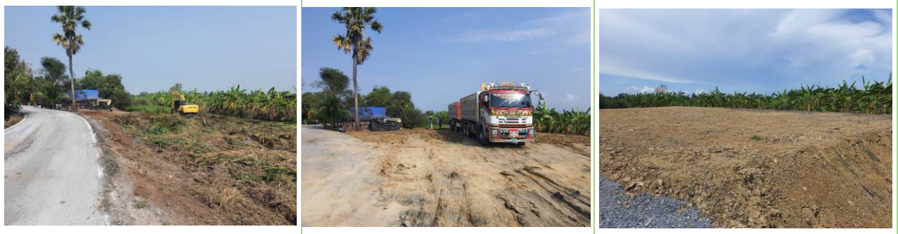
๑๙. ลงหินคลุกซ่อมแซมถนนภายในหมู่บ้านหนองปรัง หมู่ที่ ๑๑
