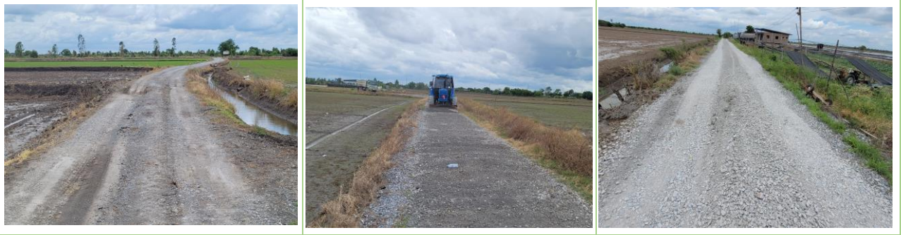
๑๗. เสริมผิวจราจรแอสฟัลท์ติกคอนกรีตสายเลียบบคลองตาพลอย หมู่ที่ ๙
