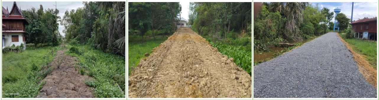
๑๓. ลงหินคลุกซ่อมแซมถนนสายเลียบคลอง สปก. หมู่ที่ ๗
