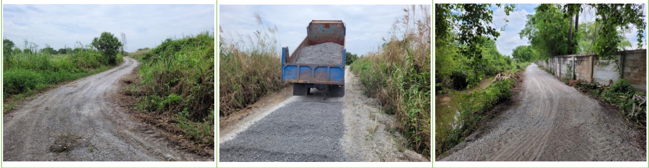
๙. ลงหินคลุกซ่อมแซมถนนสายเลียบคลอง กสช.หมู่ที่ ๖ ตำบลหินมูล
