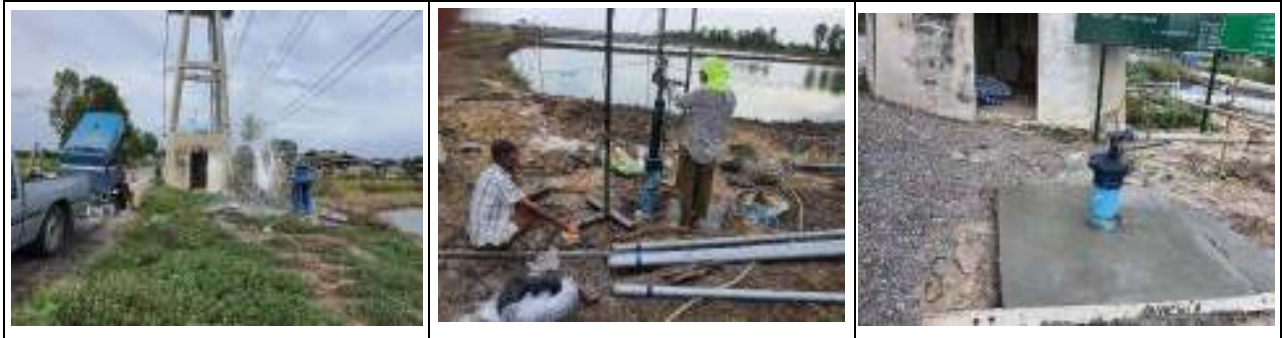
๑๓. โครงการปรับปรุงระบบประปาภายในพื้นที่ (ม.๑๐)
