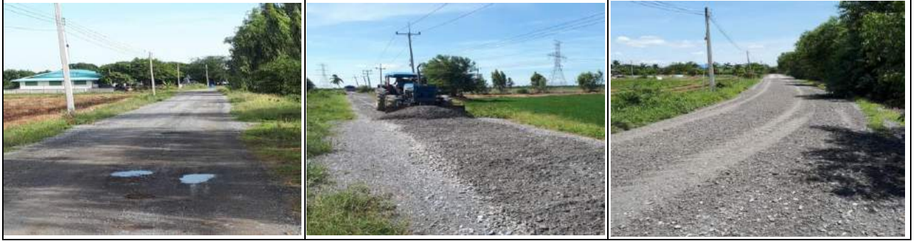
๑๒. ลงหินคลุกถนนสายเลียบบคลอง สปก.เอ เชื่อมต่อถนนสายเลียบบคลองลำรางอีสังข์ หมู่ที่ ๑๑
