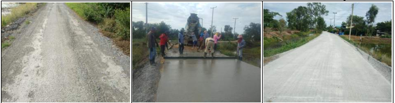
๑๔. โครงการก่อสร้างถนนคอนกรีตเสริมเหล็กสายเลียบบคลอง กสช. (ช่วงที่ ๑) ระยะที่ ๓ หมู่ที่ ๑๒
