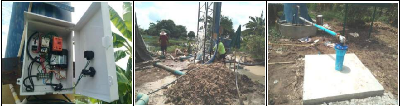
๑๖. ปรับปรุงซ่อมแซมระบบประปาหมู่บ้าน หมู่ที่ ๕
