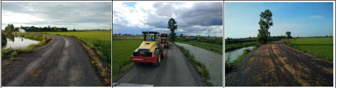
๑๓. โครงการลงหินคลุกผิวจราจรถนนสายเลียบบคลองลำรางอีสังข์ พร้อมบดอัดแน่นและราดน้ำยางไพร้มไคท์ หมู่ที่ ๑๑
