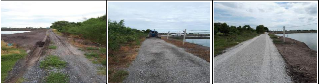
๘. ลงหินคลุกถนนสายเลียบบคลองตาพลอย (ฝั่งตะวันตก) หมู่ที่ ๙
