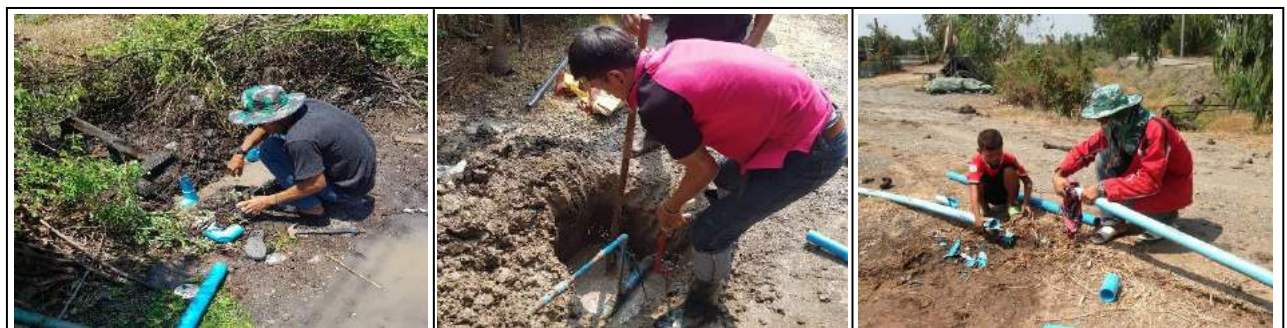
๑๕. ปรับปรุงระบบประปาภายในพื้นที่
