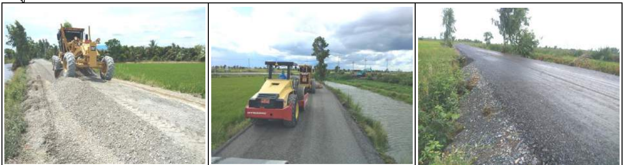
๑๑. โครงการลงหินคลุกผิวจราจรถนนสายเลียบบคลองลำรางอีสังข์ พร้อมบดอัดแน่นและราดน้ำยางไพร้มัดท์ หมู่ที่ ๑๑
