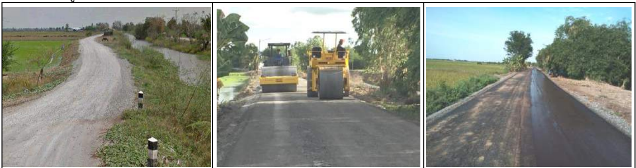
๑๐. ลงหินคลุกผิวจราจรถนนสายเลียบบคลองรางผักชี (ฝั่งตะวันออก) พร้อมบดอัดแน่น และราดน้ำยางไพร้มัดท์ ช่วงที่ ๒ หมู่ที่ ๑๐
