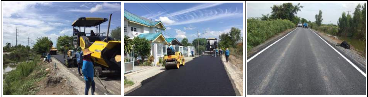
๙. ก่อสร้างถนนลาดยางแอสฟัลต์ติกคอนกรีตสายเลียบบคลองชลประทาน สาย ๒ (ฝั่งตะวันออก) หมู่ที่ ๙
