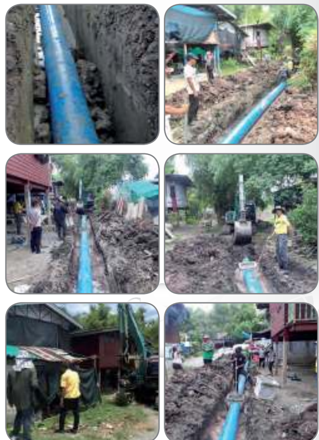
๑๑. โครงการวางท่อระบายน้ำภายในหมู่บ้าน
