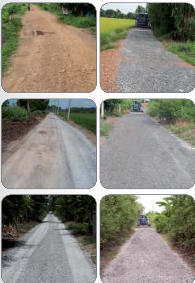
๑๐. โครงการลงหินคลุกซ่อมแซมผิวจราจรถนนภายในตำบล
