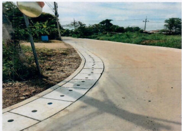
๖.โครงการก่อสร้างรางระบายน้ำรูปตัวยู (จากบ้านนายเชิด กฤษโชติ ถึง บ้านนายสมชาย สุวรรณารุท) ต่อจากเดิม หมู่ ๗
