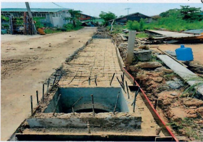
๑๑.โครงการวางท่อระบายน้ำ คสล. (ซอยบ้านนายจ้าย) หมู่ ๑๑
