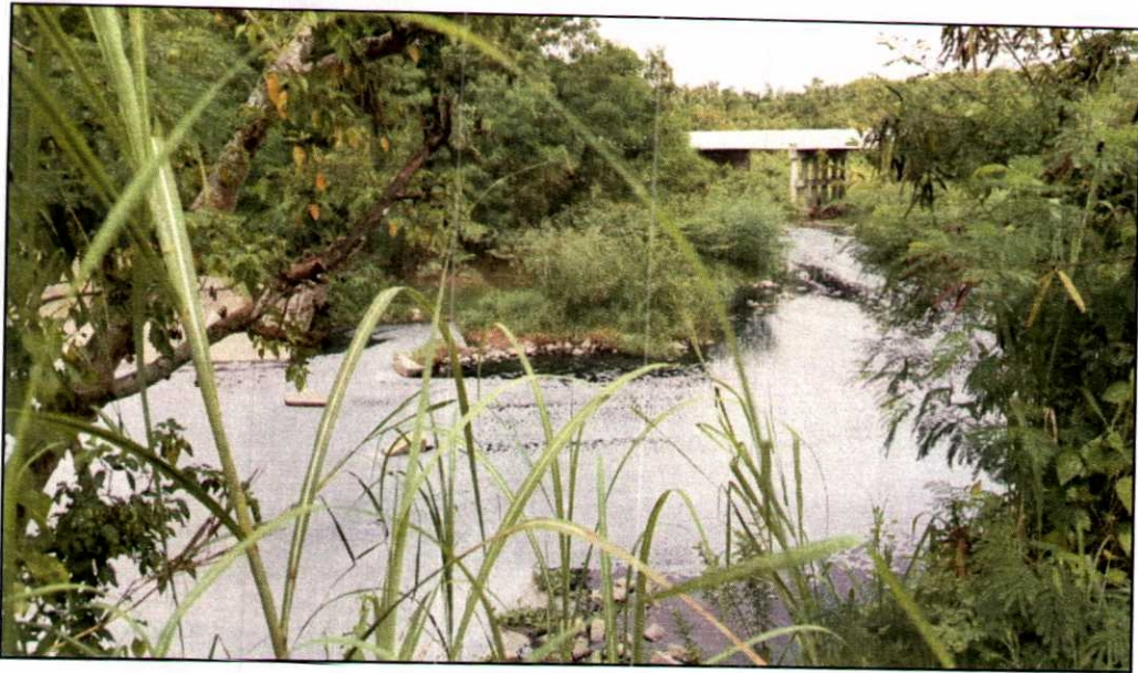
รูปภาพการตรวจสอบพื้นที่คลองหนองสรวง (วันที่ ๒๔ เมษายน ๒๕๖๐) (ต่อ)
