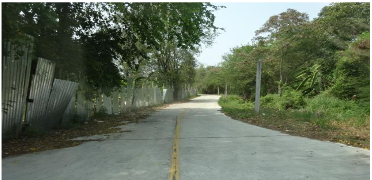
๕. โครงการก่อสร้างดาดคอนกรีตและติดตั้งกัรด์เรล บริเวณถนนทุ่งบางกระเบาแยกซ้าย หมู่ที่ ๕ ภาพก่อนดำเนินงาน
