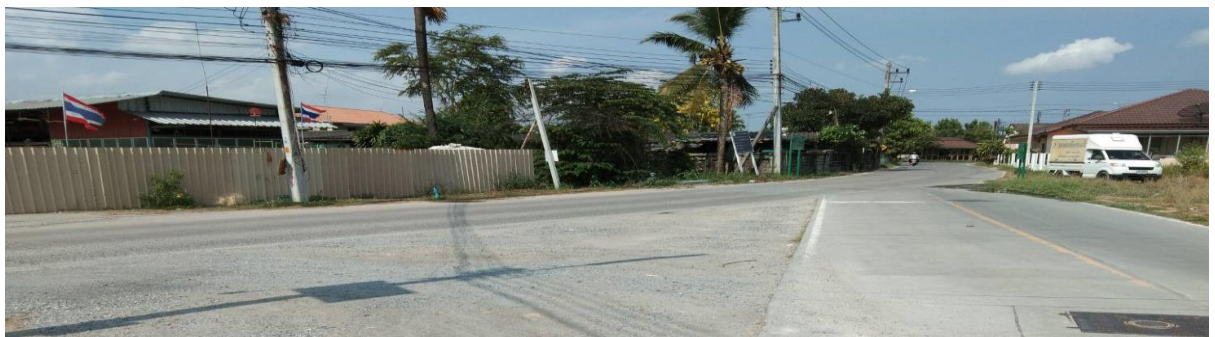
๒.โครงการก่อสร้างถนน ค.ส.ล. บริเวณซอยยุทธองพัฒนา ๓ หมู่ที่ ๔ ภาพก่อนดำเนินงาน
