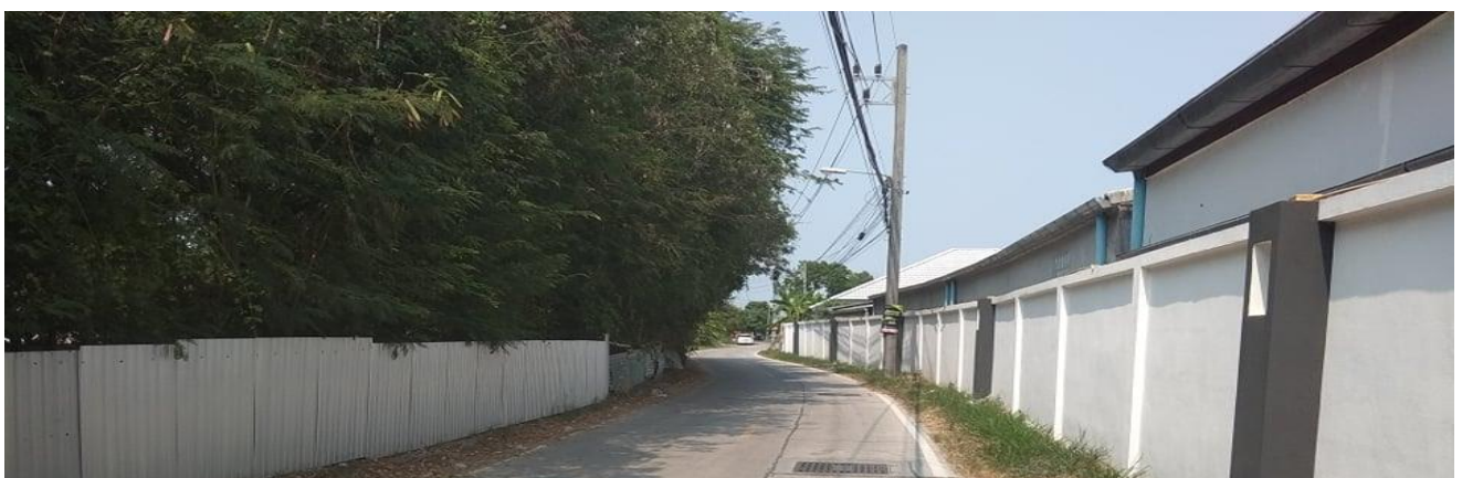
๓. โครงการขยายถนน ศ.ส.ล. บริเวณซอยโรงกาบ หมู่ที่ ๕ ภาพก่อนดำเนินงาน
